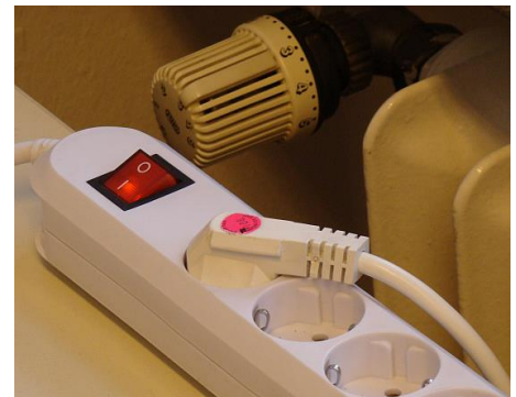
Schaltsteckdose und Thermostat helfen beim Energiesparen
