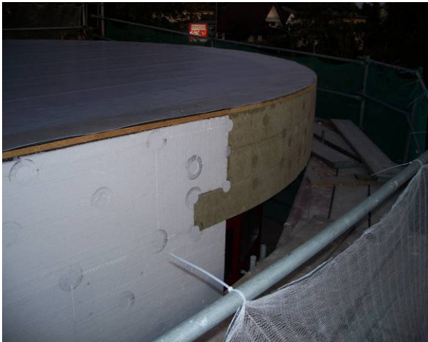
Baumaßnahmen zur Wärmedämmung in der Kita, 2010.
